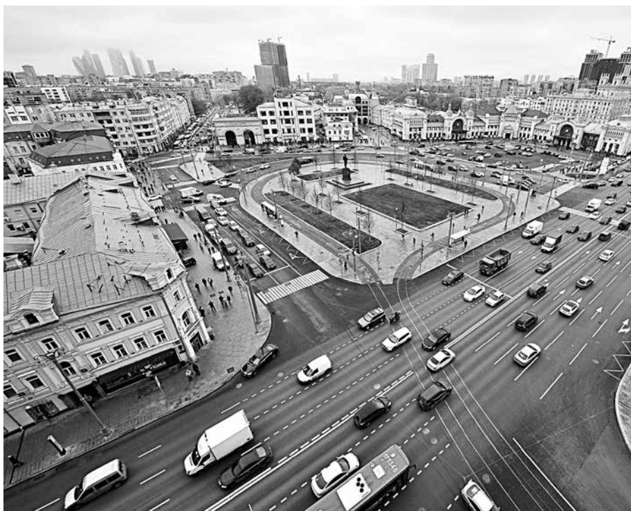
Площадь Тверская Застава после реконструкции. Вид со стороны ул. Лесная
